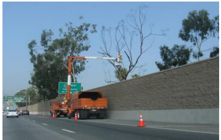
Los conos de tráfico delimitan una zona de seguridad.
